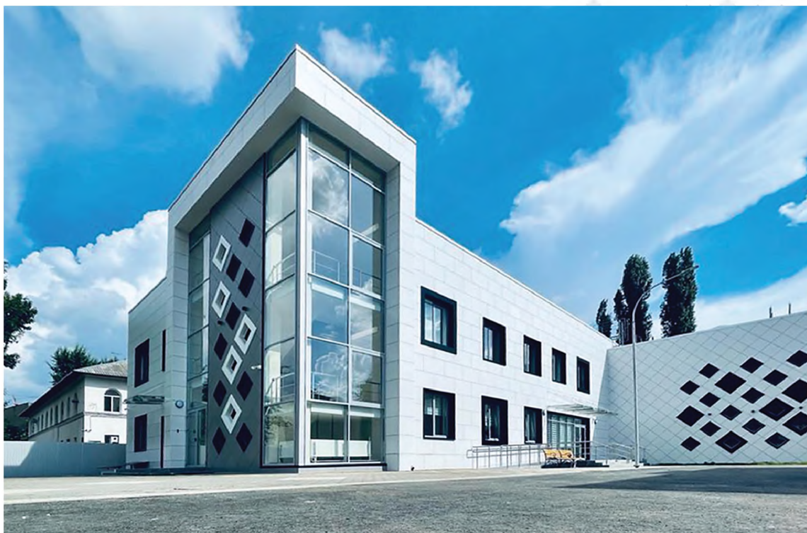
Новый радиотерапевтический корпус на улице Электросигнальной, 13
