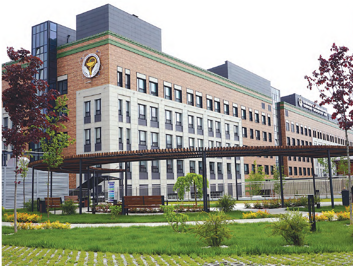
Новый хирургический корпус Воронежского областного клинического онкодиспансера
