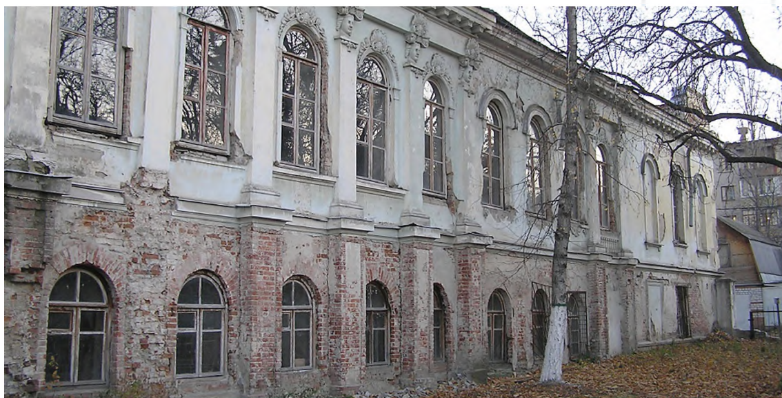
Исторический памятник Дом Вигеля до реконструкции
