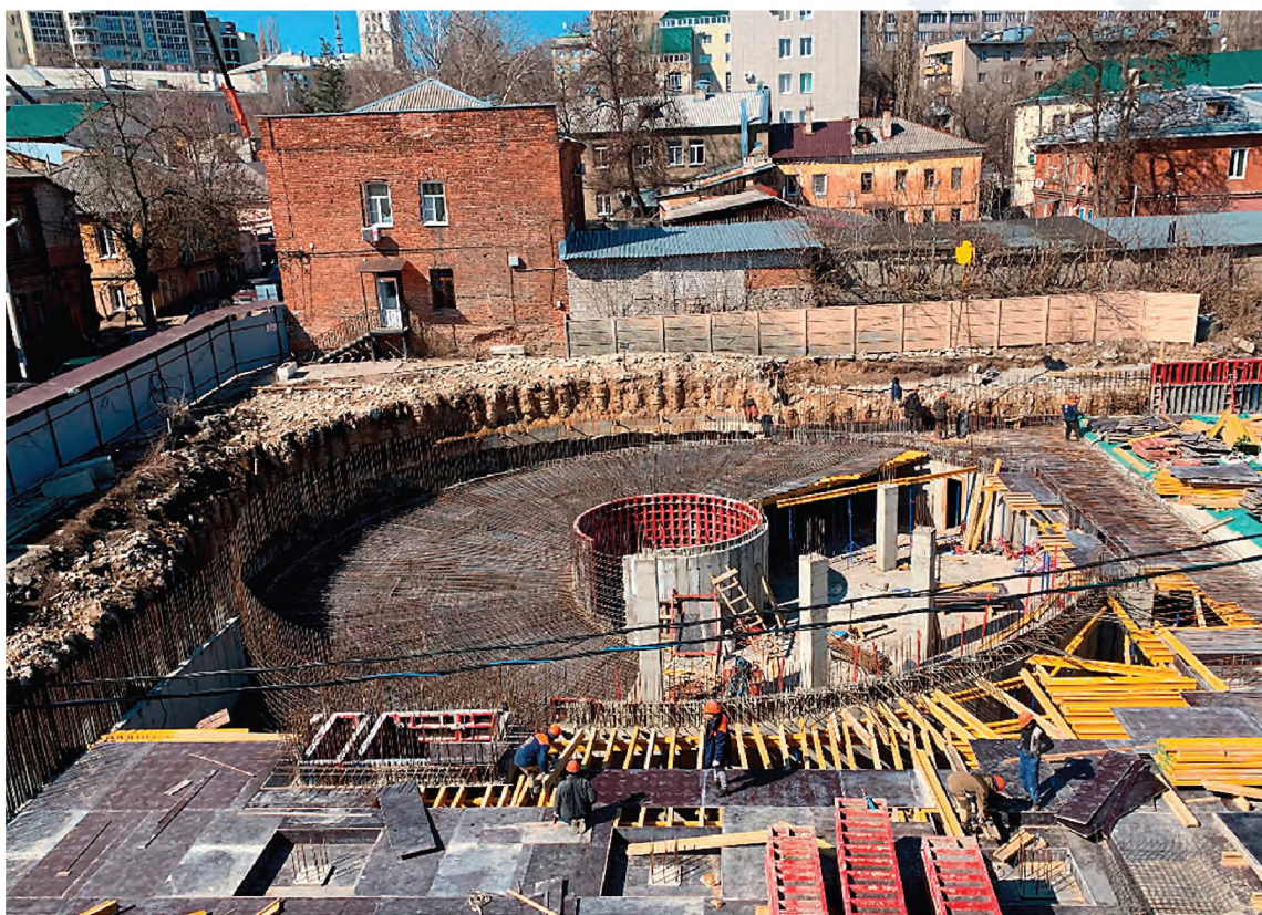
Строительство подземной парковки
